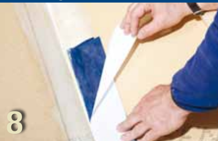
Verklebung Unterdach Holzweichfaser
