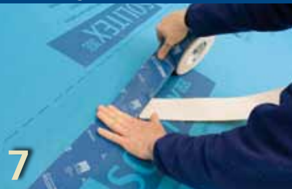
Verklebung Unterdach SOLITEX
