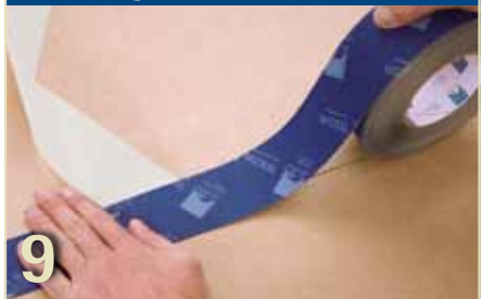
Verklebung Unterdach MDF
